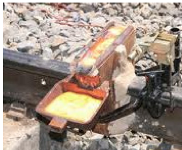
Aluminotermijsko zavarivanje
