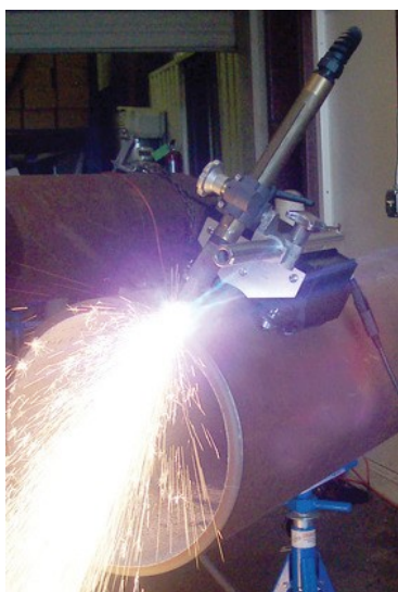
Zavarivanje cijevi velikog promjera
